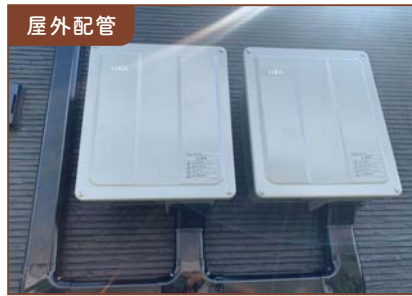
屋外配管 パワーコンディショナへの配管・配線が外壁材の外側を通ります。
