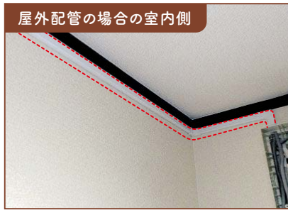
屋外配管の場合の室内側 屋内側の配線が内壁材の外側を通る場合があります。(赤点検口部)
